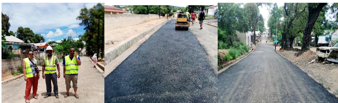
Figure 1 : Figure montre la mise en œuvre de la couche de roulement sur la route d'Ambilobe Madagascar.
