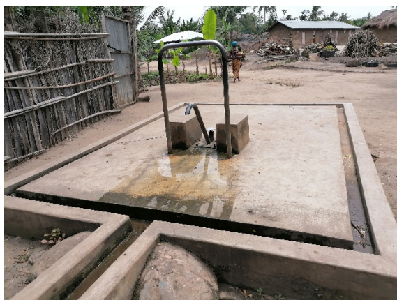
Photo 3 : Forage équipé de pompe à motricité humaine à Koudohounhoué (Athiéomé). (Prise de vues : Amouzounvi, mars 2022).
