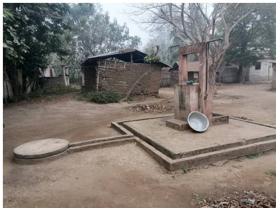
Photo 2 : Borne-fontaine à Djondji-Zounmè dans la commune de Lokossa. (Prise de vues : Amouzounvi, mars 2022).
